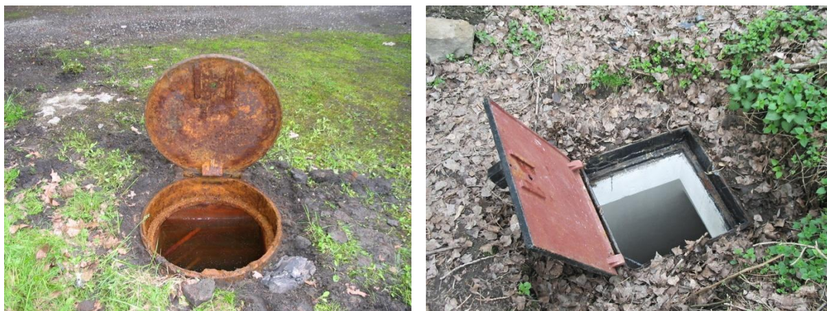
Obr. 26, 27: kruhový poklop na komoře 12/I./B (vlevo) a jeho čtvercové provedení na komoře 1124/B (vpravo) (foto: Petr Bělošický 2005, 2008)
