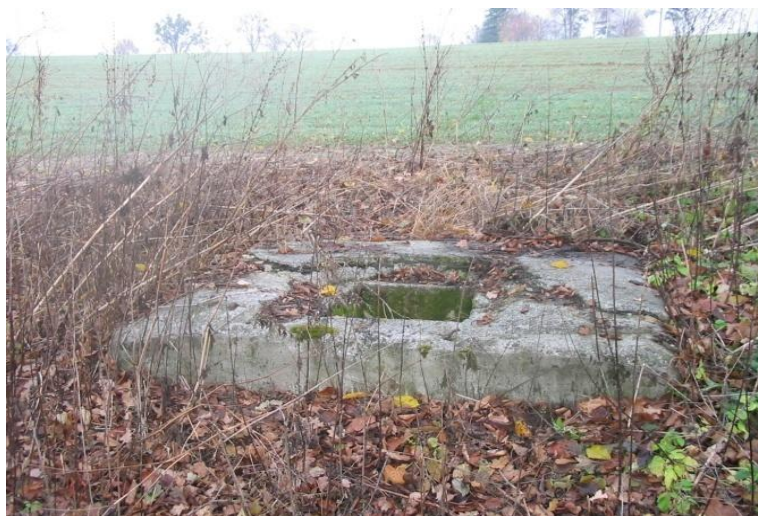
Obr. 10: kabelová studna 2141/C. (foto: Petr Bělošický, 2006)
