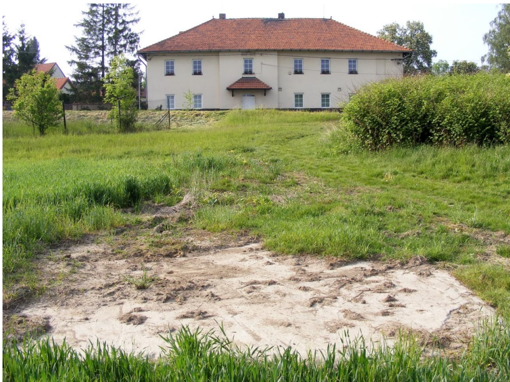
Obr. 11: kabelová komora 55/I./B a budova bývalého hostince Laterna v pozadí (foto: Michal Varyš, 2009)
